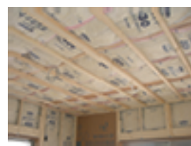
断熱材施工様子
